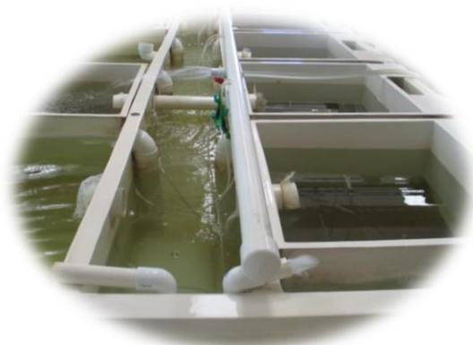
En el manejo del asentamiento remoto tradicionalmente realizado, se necesita una infraestructura establecida en tierra, compuesta principalmente, de un sistema hidráulico de captación, filtración, abastecimiento y distribución de agua de mar, sistema de aireación, tanques con volúmenes compatibles; además de adquisición de grandes volúmenes de microalgas, para el alimento de las
